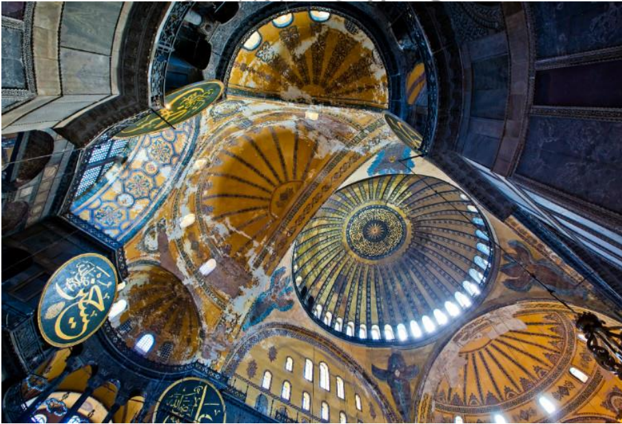
الشكل (٢) يوضح استخدام التكتيف في القباب والمقرنصات
